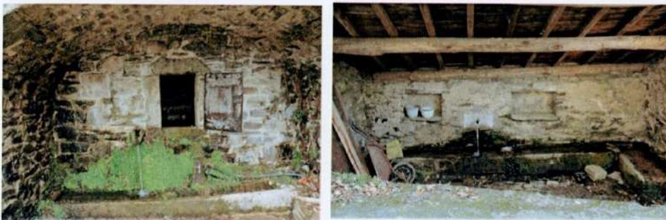
La fontaine de Massevaques / La fontaine du village
